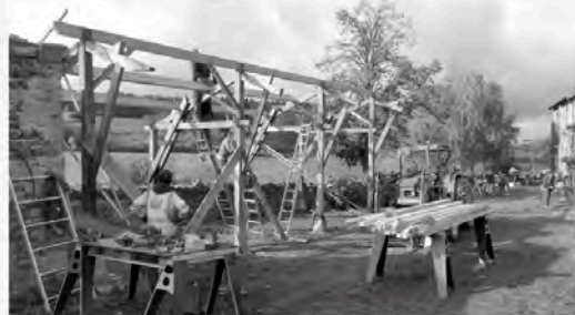
Hungar en bois massif avec assemblages traditionnels, chantier pédagogique, l'Atelier paysan, 2021
