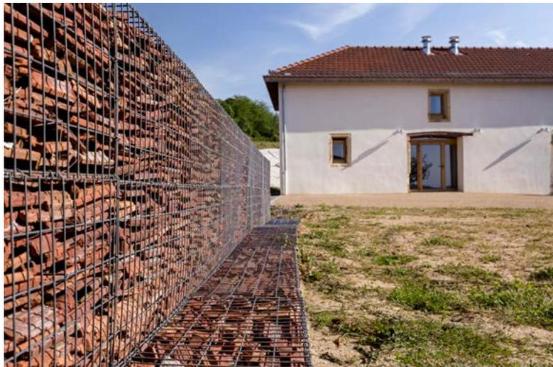
Les tuiles des toitures existantes ont été réemployées soit dans leur fonction initiale en couverture, soit en contre-cloison acoustique, soit en gabion de soutènement.
