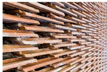
Cet appareillage en tuiles de réemploi est favorable pour une contre-cloison acoustique.
