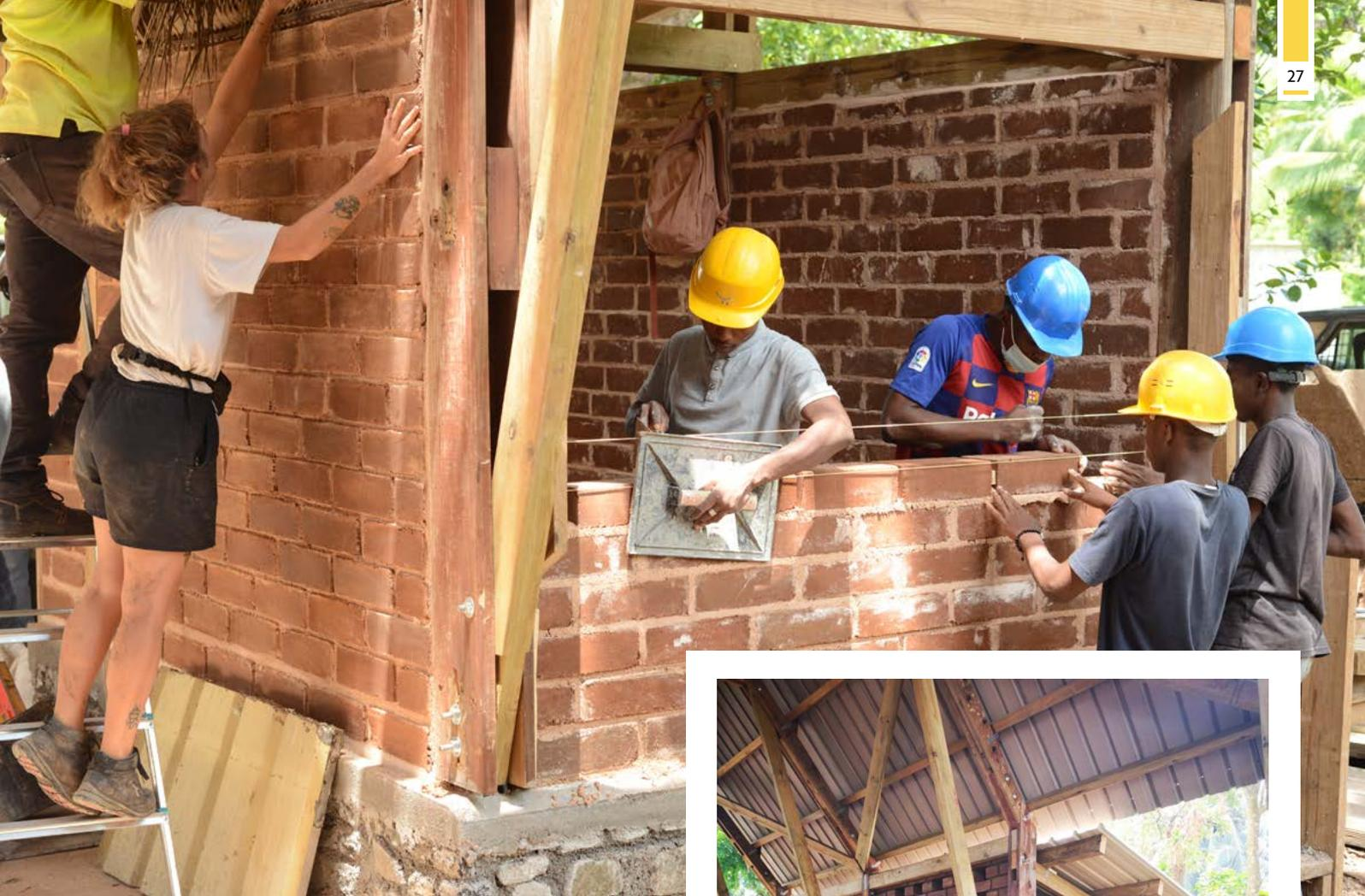
Ce sont des lycéens qui ont posé les blocs de terre comprimée en remplissage de l'ossature en bois dans le cadre d'un chantier-école.
