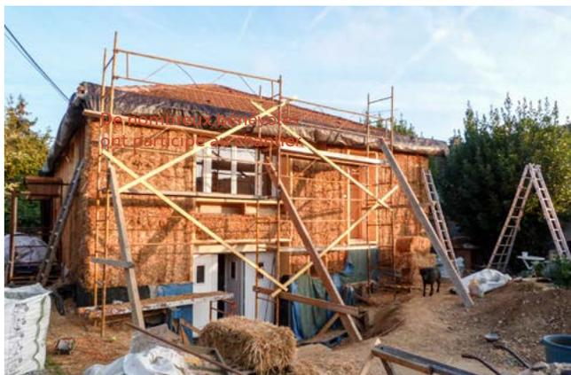
Le tiers inférieur du mur de l'immeuble de Paris Habitat est isolé par des bottes de paille en suspension, le reste par la technique plus classique de la paille entre des montants verticaux.
