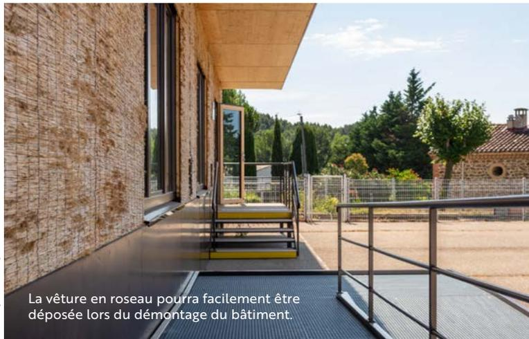
La vêtue en roseau pourra facilement être déposée lors du démontage du bâtiment.
