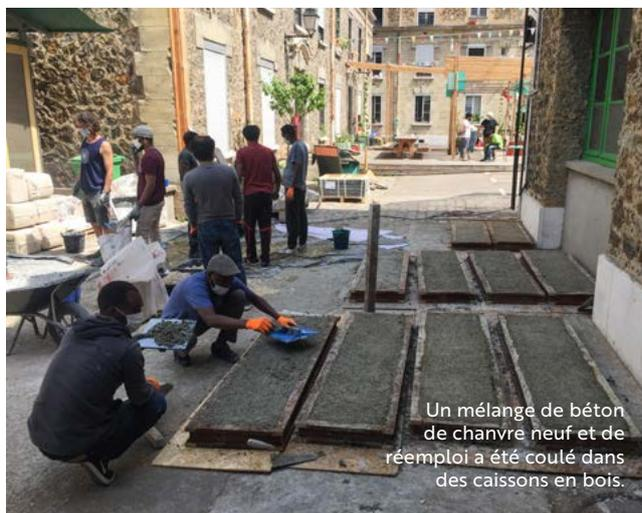
Un mélange de béton de chanvre neuf et de réemploi a été coulé dans des caissons en bois.
