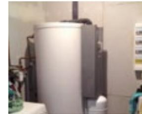
Récupération d'énergie sur les eaux usées de douche pour préchauffage de l'eau froide (type Gaia green).
