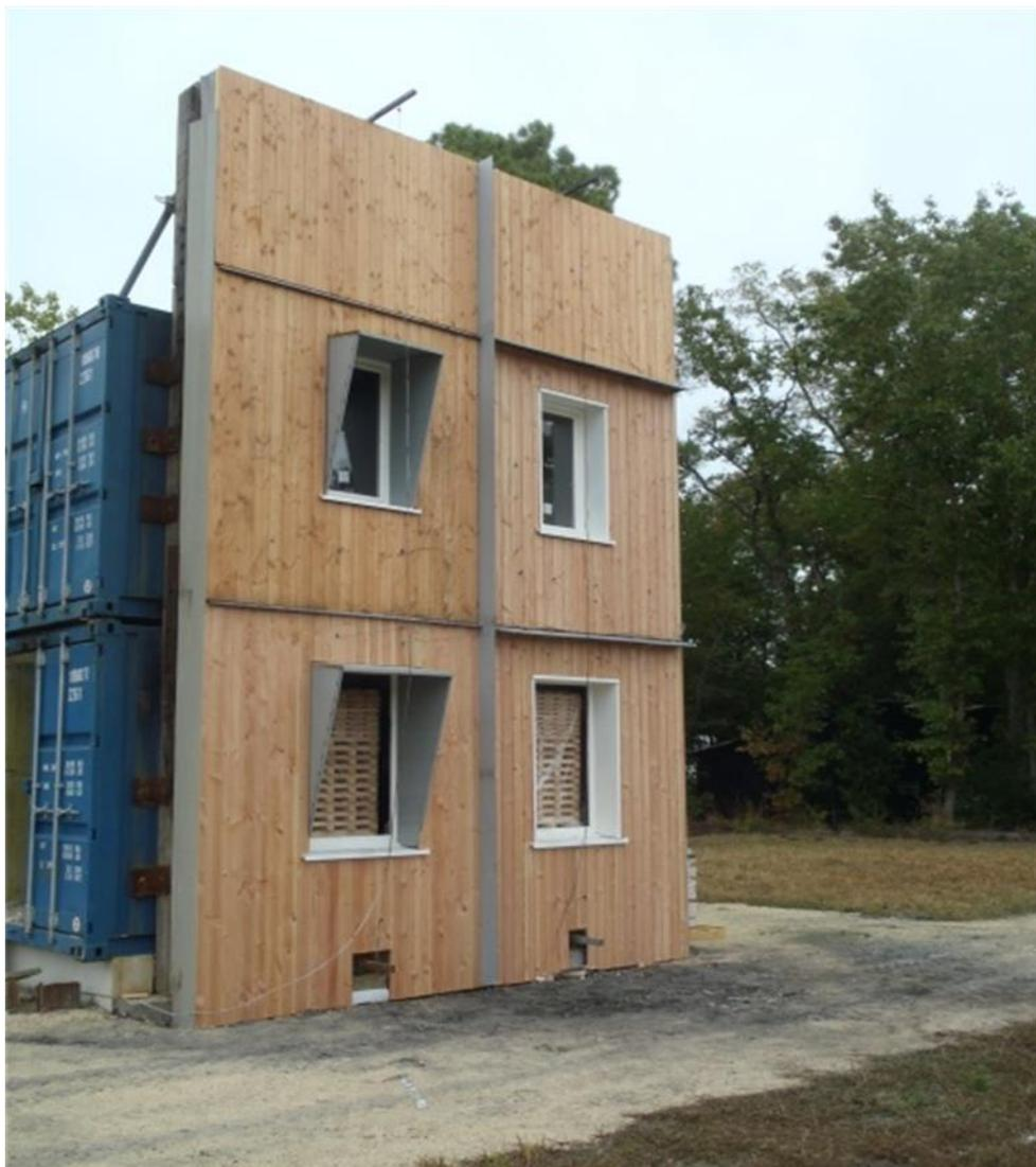
Bardage en lames **verticales de Douglas** de section 26 x 125 mises en œuvre sur support de bardage en bois de section 25 x 38
