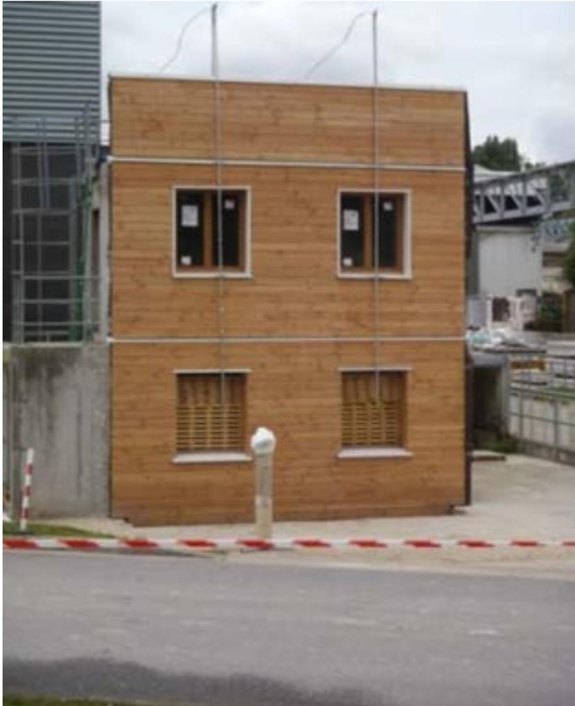
Bardage: Lames de Douglas de section 21 x 143 mises en œuvre sur support de bardage en bois de section 27 x 27
