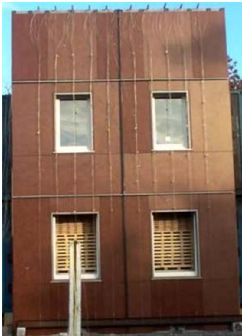
Bardage en panneau stratifié HPL Polyrey, à base de papier (65%) et de résine thermodurcissable (35%), Euroclasse : B-s1, d0, Epaisseur 8, mis en œuvre à joint fermé
