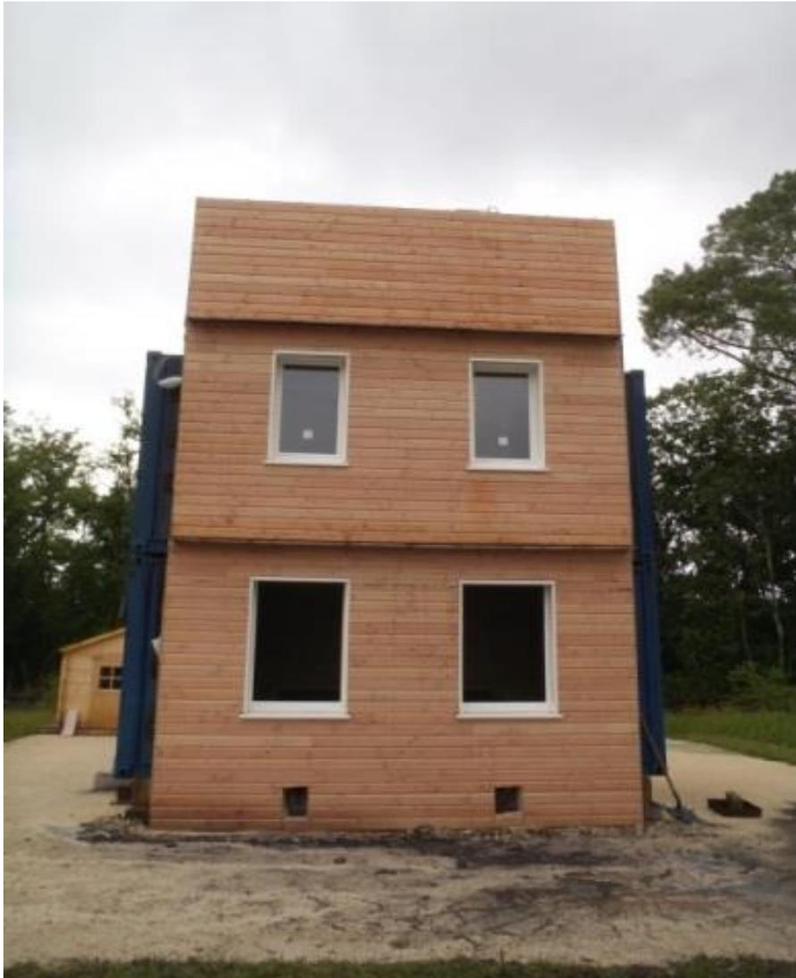
Bardage: Lames de **Douglas** de section 26 x 125 mises en œuvre sur support de bardage en bois de section 25 x 38
