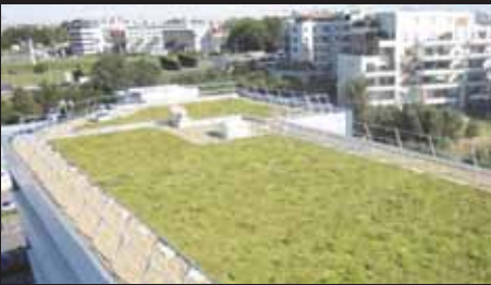
Toitures vertes extensives
