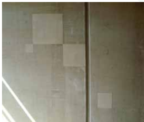
Figure 58 – Patch ciment sur béton, architecte : Méandre – Photo : Marie-Pierre Goguet
