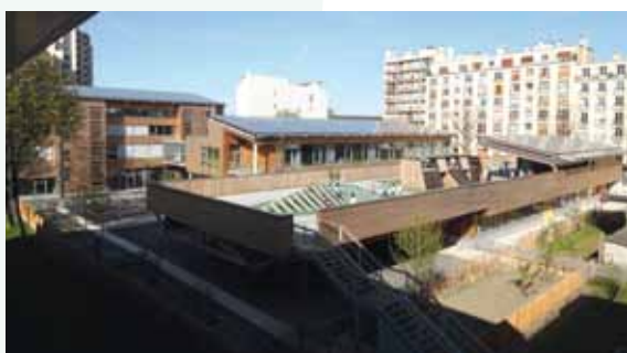
Figure 14 – École zéro énergie à Pantin architecte : Méandre – Photo : Olivier Wogenscky
