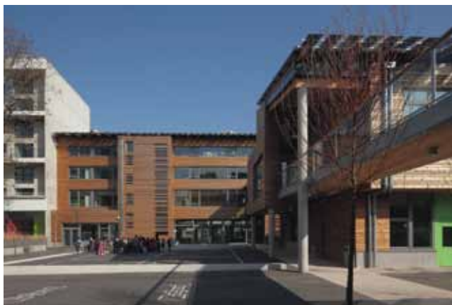
Figure 13 – École zéro énergie à Pantin architecte : Méandre – Photo : Olivier Wogensky
